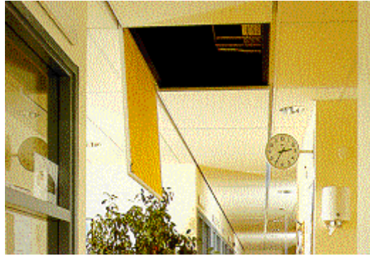
Ejemplo de techo acústico en forma de paneles absorbentes. Se puede observar la cavidad existente entre el techo real y el falso. (fig.5)
